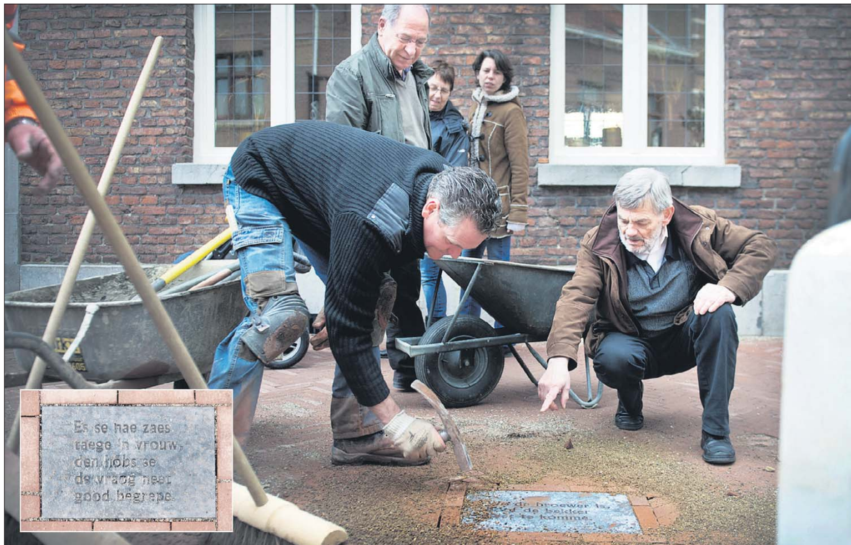
Een stratenmaker legt één van de tegels op de juiste plaats. Piet Aben (rechts) en Ton van Wegberg kijken toe.
